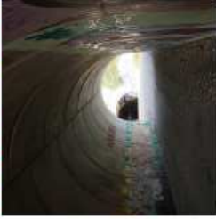
PASO SUBTERRÁNEO UNDERPASS 38°28'15,1"N 0°24'08,3"W
